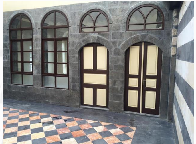
بيت جدي أسعد في الطابق السفلي الارضي وفي هذا البيت ايضا عاشت عائلة موسى حانونو وابنائهم .
